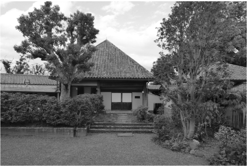
図1 三樹庵玄関正面外観
